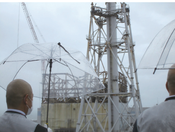
東京電力福島第一原子力発電所にて
